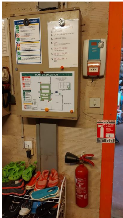
Salle 2 à côté de l'alarme Et du plan d'évacuation
