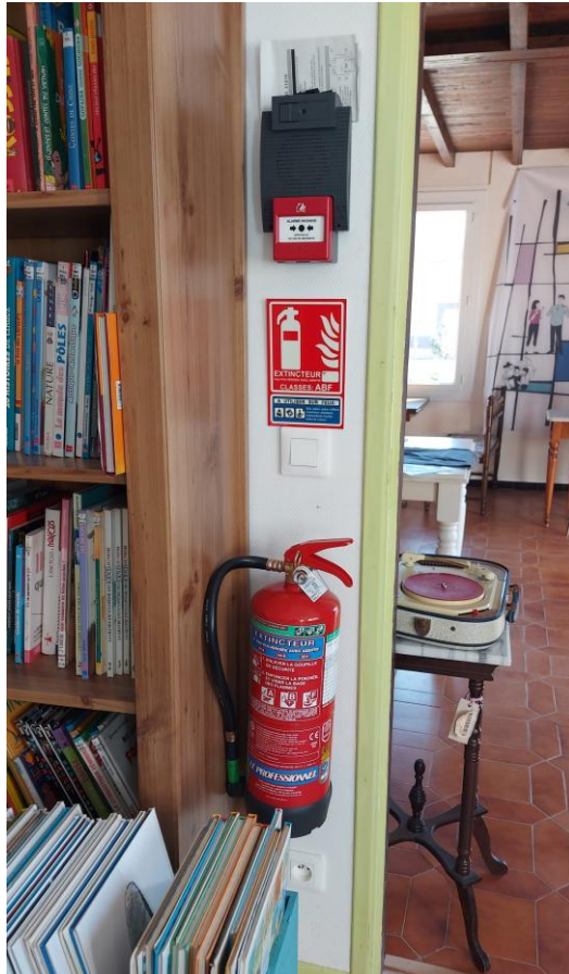
Mur séparation côté bibliothèque
